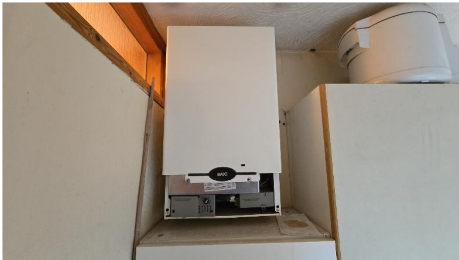
Baxi Solo 3 PFL 50 non condensing boiler
