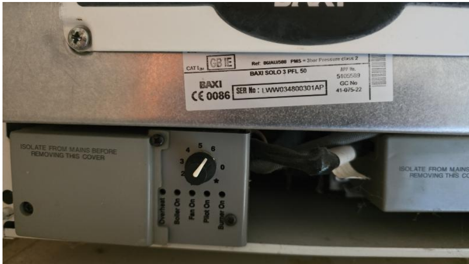
Baxi Solo 3 PFL 50 non condensing boiler
